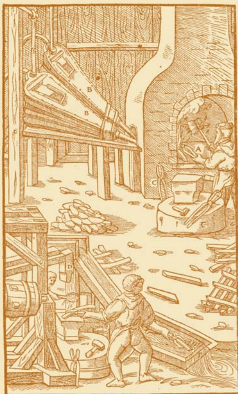
Горн А. Межа В. Щипцы С. Молот D. Водяной поток E.
