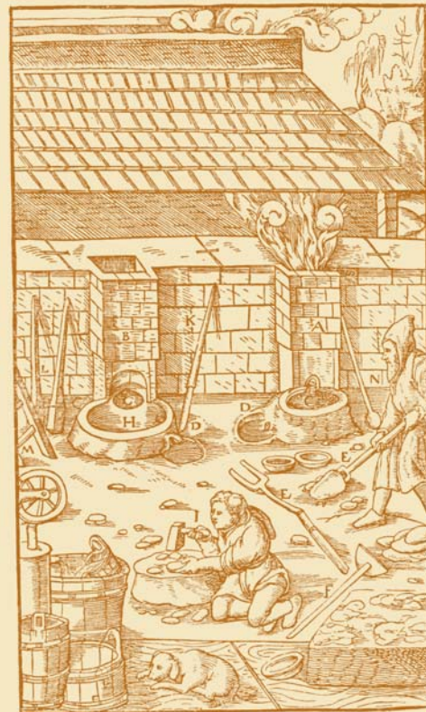
Две печи A, B . Передний горн C . Нижний горн D . Мастер стоит у печи и железными вилами извлекает шлаки. Железные вилы E . Деревянная мотыга, которой извлекают штейн, F . Часть переднего горна, находящаяся внутри второй печи. G . Наружная часть H . Помощник приготавливает передний горн, который показан отдельно от печи, I . Лом K . Деревянный пест L . Лестница M . Черпак (ковш) N .
